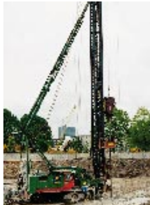
Abb. 46: Bagger mit Bohreinrichtung
